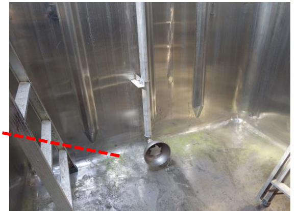
③蒸気吹き込み口取付
