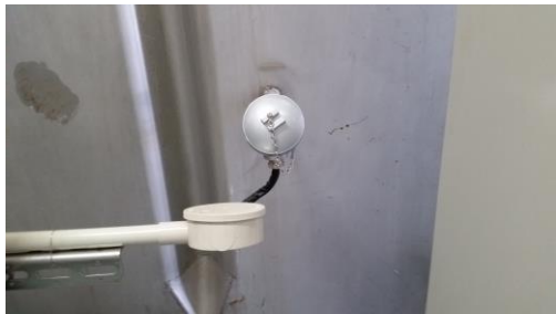
①温度計取付座取付
